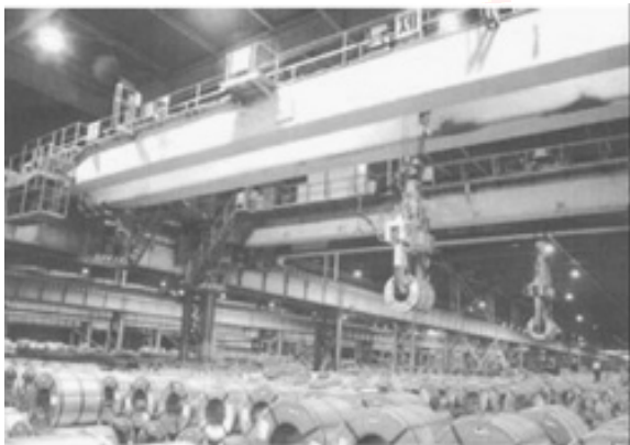
รูปที่ 11 แสดง เครนในโรงงาน (Hoist)
